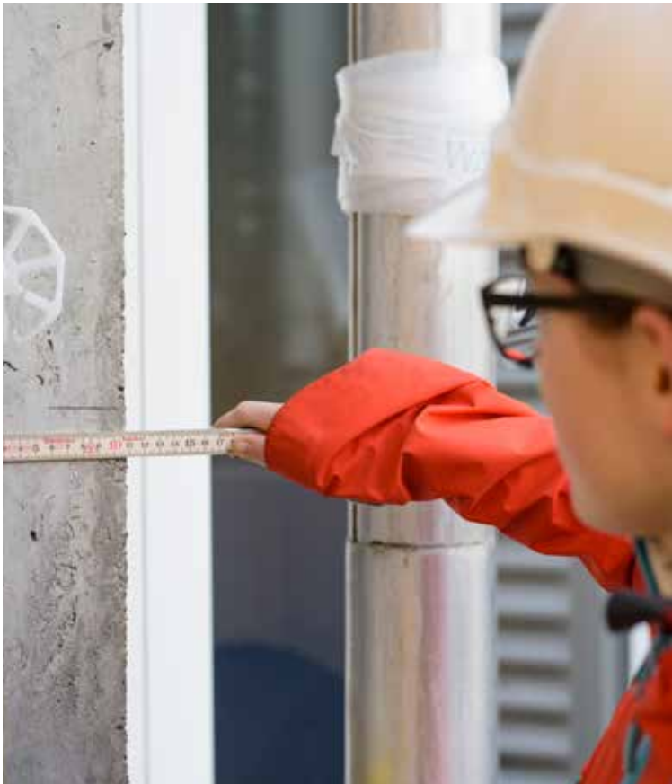
Prise de mesures La dessinatrice-constructrice sur métal commence par prendre les mesures précises sur le chantier. C'est une étape importante en vue de la planification qui suit.
